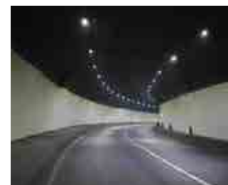
四川 米亚罗小丘地隧道
