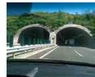
四川 米亚罗小丘地隧道
