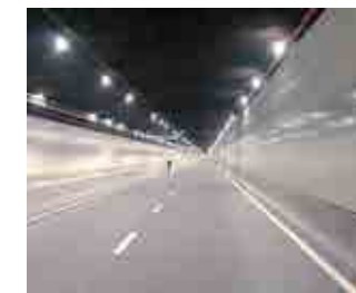
西安 2021通往奥体中心隧道
